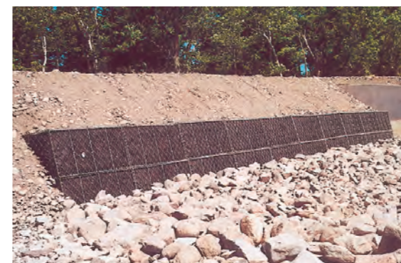
ロック・ウォール(片法勾配タイプ)施工例
