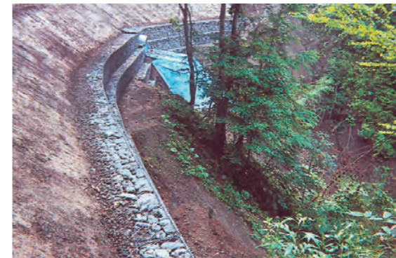
ロック・ウォール(片法勾配タイプ)施工例
