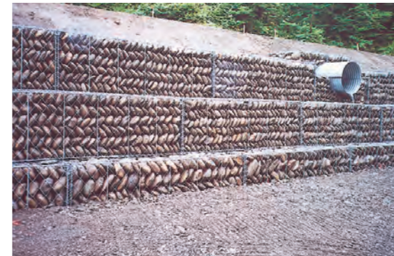
ロック・ウォール(パネル標準タイプ)施工例
